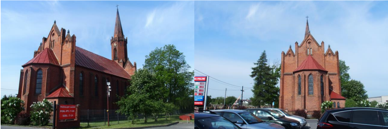
Zdjęcia nr 9, 10. Kościół pw. Wniebowzięcia NMP, Dąbrowa Biskupia
